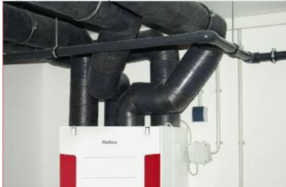
Соединение компонентов IsoPipe
