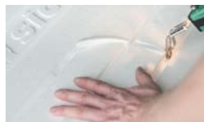
Дополнительные каналы могут быть выпилены электроинструментом
