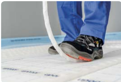
Просто прижмите трубу подошвой к поверхности панели
